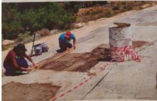
Inwoners en werkers in Desember verlede jaar besig om slaggate in een van die paaie op Koingnaas te herstel. FOTO'S: VERSKAF
